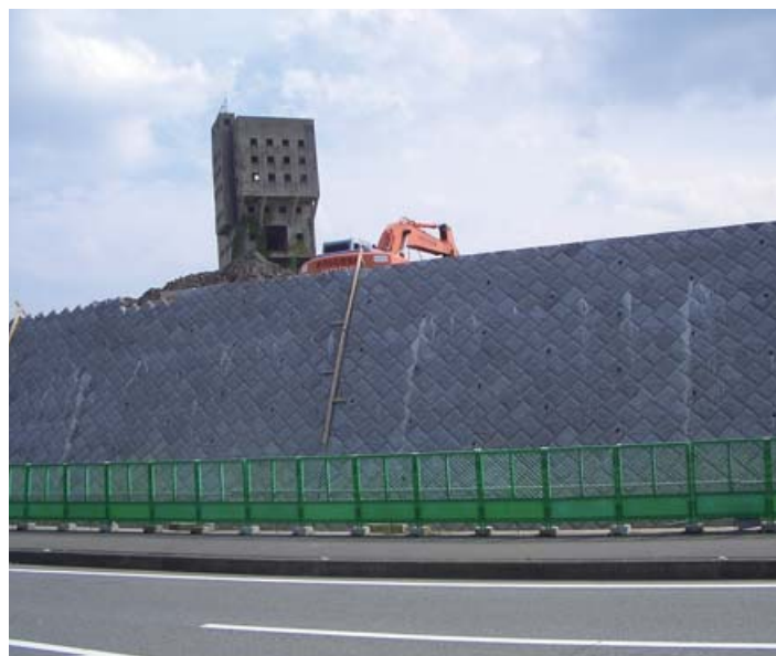
▲炭鉱跡地擁壁工事
