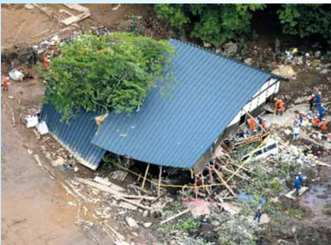
岩手・宮城内陸地震の被害状況
