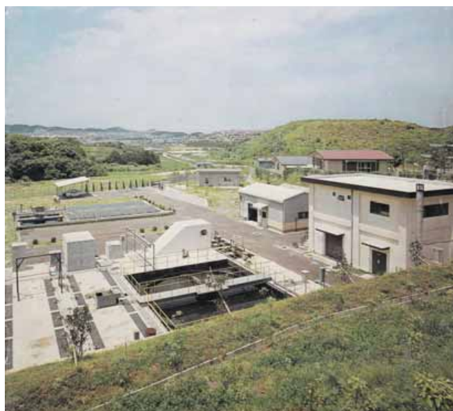
▲竣工時(昭和46年)の桜丘下水処理場
