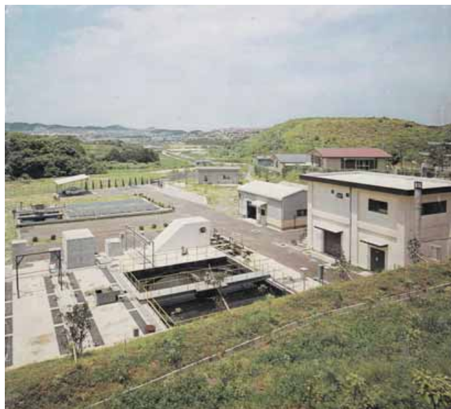
▲竣工時(昭和46年)の桜丘下水処理場
