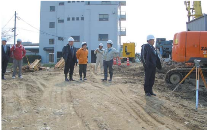
御手洗附近的宇美川右岸の工事現場
