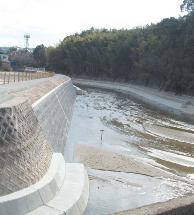
片峰新橋上流の工事現場
