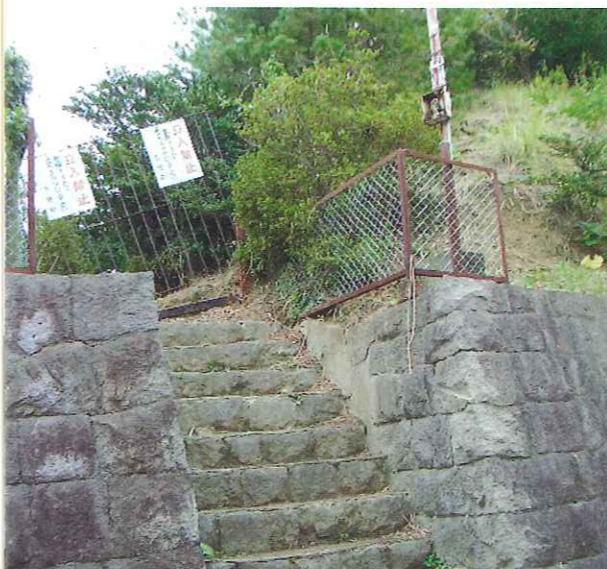
▲板付ハイツ配水池
