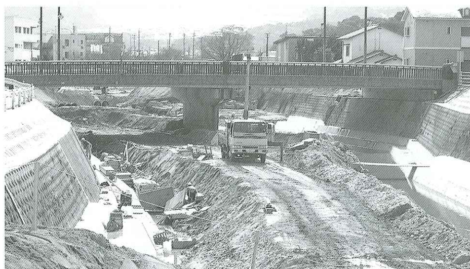
写真 宇美川河川工事
