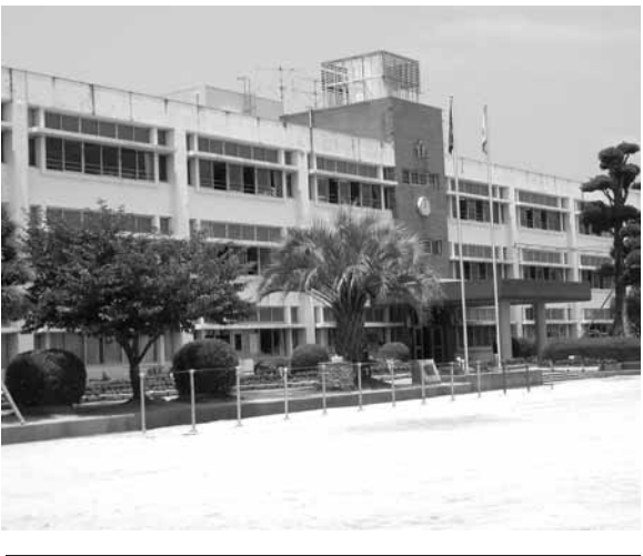
写真 志免中央小学校校舎
