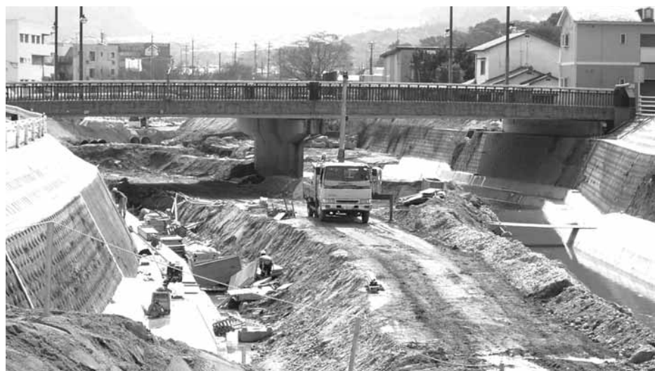
写真 宇美川河川工事
