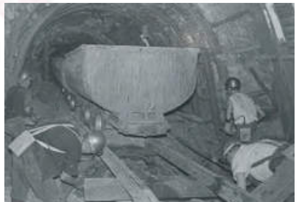
坑道内での作業
