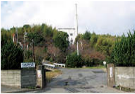
旧し尿・ゴミ焼却施設の解体撤去が完了 平成16年10月
