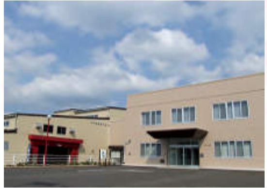
「宇美志免リサイクルセンターエコル」稼働 平成21年4月
