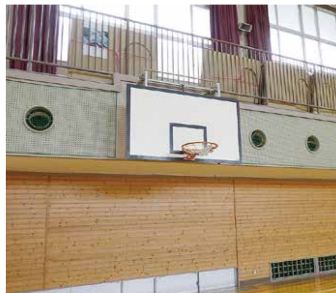
エアコン設置体育館 行橋小学校
