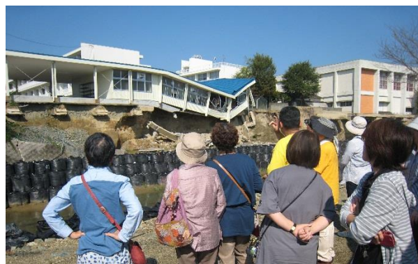
▲ 朝倉市水害の現地視察の様子
