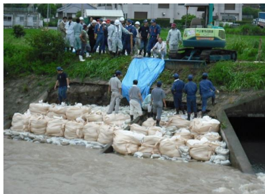
堤防損壊直後の応急作業
