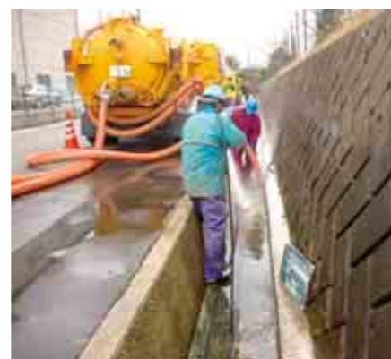
▲きれいになった排水路
