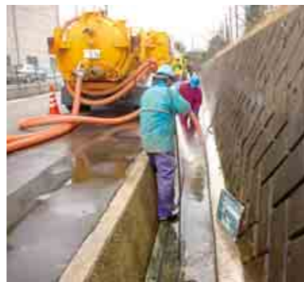
▲きれいになった排水路
