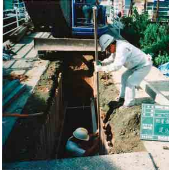
▲下水道整備も進んでいます
