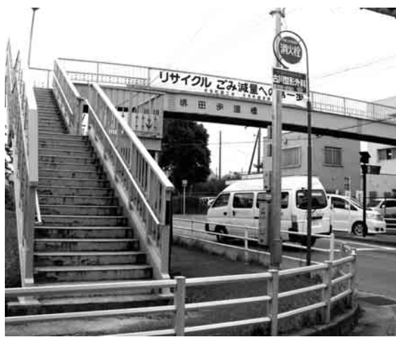
写真 堺田歩道橋 (東小学校前)
