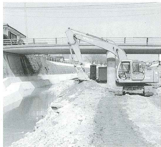
写真 宇美川改修工事
