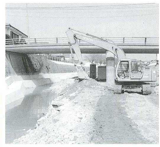
写真 宇美川改修工事
