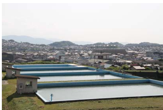
土生山浄水場(緩速ろ過池)
