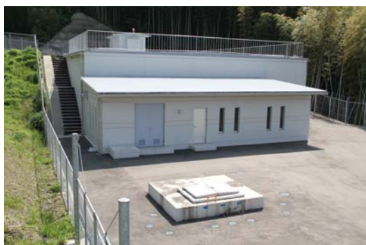
桜丘低区配水池
